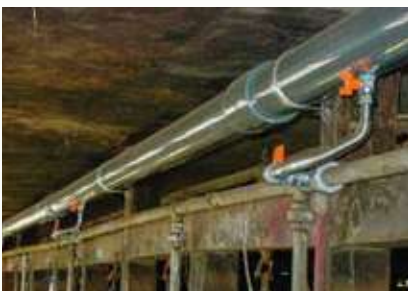
写真4) 貯水管設置により吐水量増加
