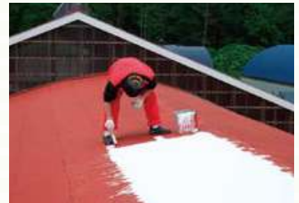
写真3) 遮熱塗料でふく射熱対策
