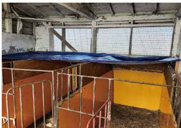
写真2)柵の側面に板を取り付け
