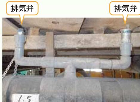
写真4 口径を太くした水道管に接続した吸気弁・排気弁の設置例
