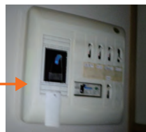
（写真5）蓄光テープの貼付例 電灯スイッチ⑦、ブレーカーボックス⑧
