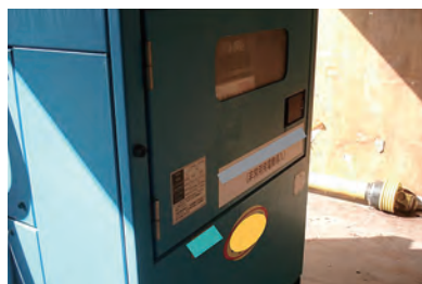
（写真1）PTO駆動式発電機⑤と牛舎壁面の電源切換盤⑥
