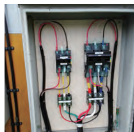
（写真1）PTO駆動式発電機⑤と牛舎壁面の電源切換盤⑥
