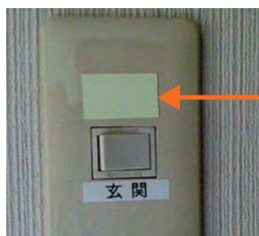
（写真5）蓄光テープの貼付例 電灯スイッチ⑦、ブレーカーボックス⑧
