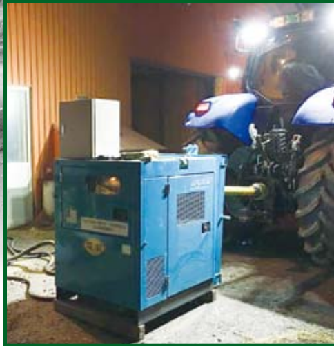
J Aの発電機を運用し搾乳中！
