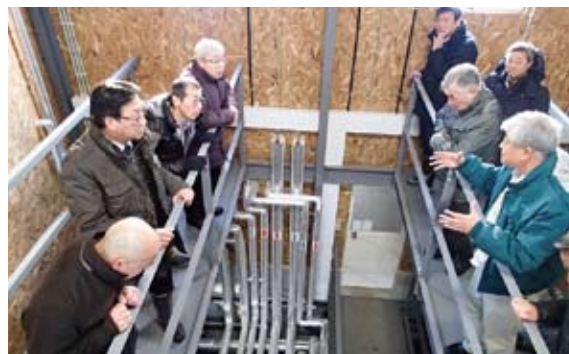
清水町 バイオガスプラント施設内
